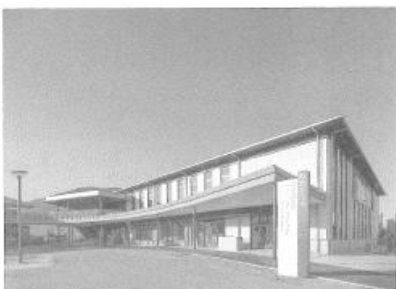
《写真1 北東面全景》
